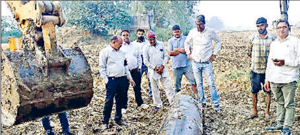
हंसी। पानी निकासी के लिए बिछाई गई एचडीपीई पाइपलाइन की जांच करती सीएम फ्लाइट्स टीम।
